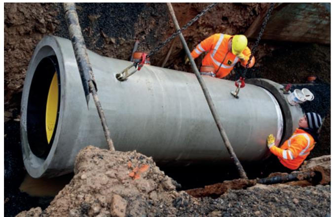
Многочисленные проекты в Америке, Азии и Европе наглядно свидетельствуют о преимуществах трубы Perfect Pipe: защита от коррозии, долговечность, герметичность, высокая статическая несущая способность и простота укладки
